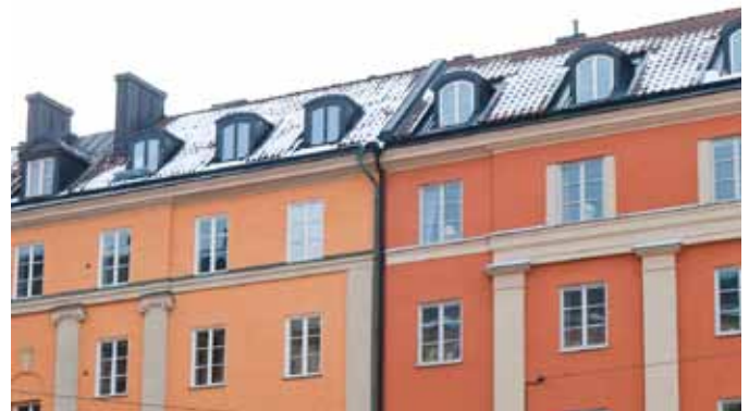
10. Nya kupor, i ena fallet med samma kulör som takmaterialet, svarta, vilket gör att de läses ihop med taket, medan de som är vita mer anknyter till fönstren på fasaden. Beroende på vilket intryck man är ute efter ger valet en tydlig effekt.
