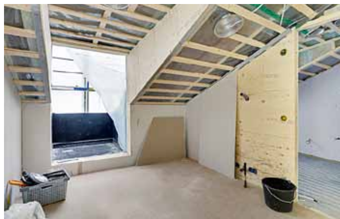
33. Exempel på indragen takterrass under byggnation
