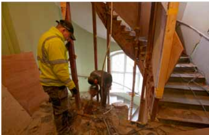
31. Installation av ny hiss i befintligt trapphus.
