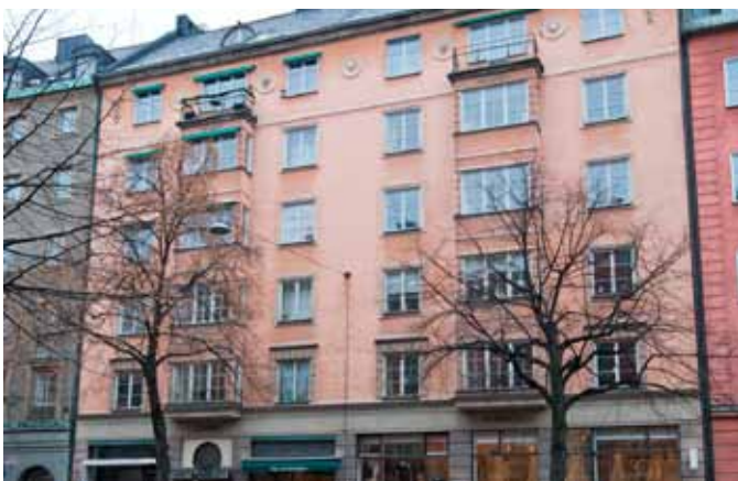
5. Hus i stenstaden. Lägga märke till bottenvåningen med sitt kraftfulla uttryck och jämför med fasadens mer lätta dekorerade uttryck med burspråk som kröns av små balkonger. Taket avslutar byggnaden med sin stora sammanhållna takyta av skiffer och två små lunettformade kupor.
