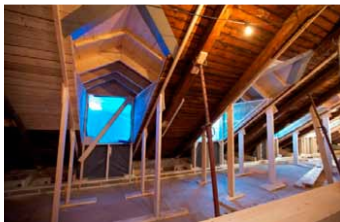
34. Byggnation av nya kupor i befintlig tak
