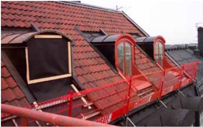
11. Exempel på välvd takkupa med profilerad takfot av plåt.
