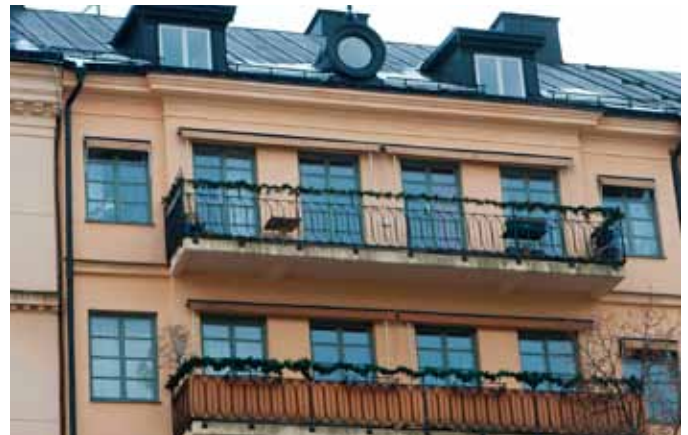
13. Två nya och en ursprunglig kupa med fri placering i förhållande till fönstren på fasaden.
