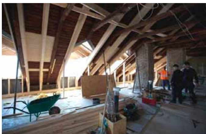
32. Pågående bygge, inredning av råvind till bostad.
