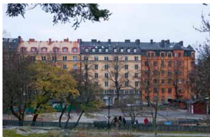
3. Flerbostadshus vid Högalidsparken med olika takkupor
