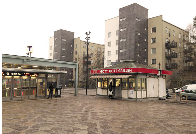
12. Detta gatukök i Tensta är cirka 30 kvm och anpassat till den storskaliga miljön vid tunnelbanan och höghusen. Detaljplanen anger att området får användas för centrumbebyggelse.
