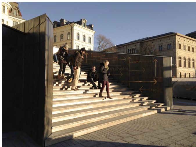
11. Denna serveringsbyggnad på Strömkajen är utformad så att väggen och taket ger soliga sittplatser för allmänheten med utsikt över vattnet. En särskild detaljplan gjordes för att möjliggöra denna byggnad och två intilliggande byggnader.
